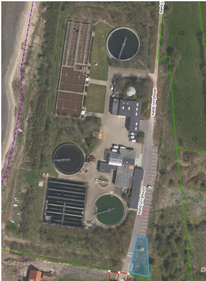
Figur 3.2: Lemvig Renseanlæg, der nedrives og placering af ny pumpestation (blå skraveret).
